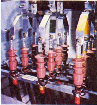
Fig. 15.44. Barras colectoras de corriente de aluminio en una instalación de conmutación de tensión intermedia.
