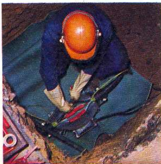
Fig. 14.12. Aislamiento del punto de trabajo al reparar un empalme de cables sometidos a tensión.
