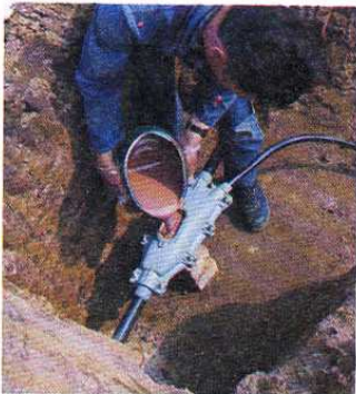
Fig. 15.107. Relleno de un empalme de cables con resina fundida.
