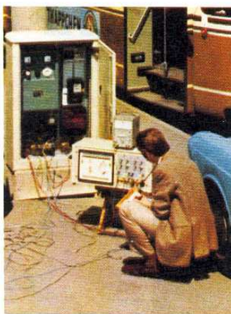
Fig. 13.82. Medidas en una canalización de tubos afectada por corrientes derivadas.
