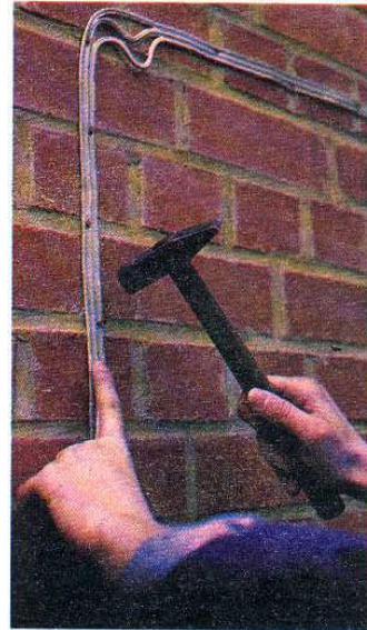
Fig. 15.13. Fijación de una línea plana. Unidad Operativa SENATI - Abancay
