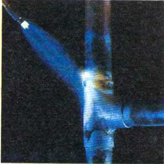
Fig. 15.106. Soldadura fuerte.
