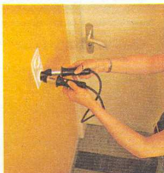
Fig. 14.17. Comprobación de la ausencia de tensión.
