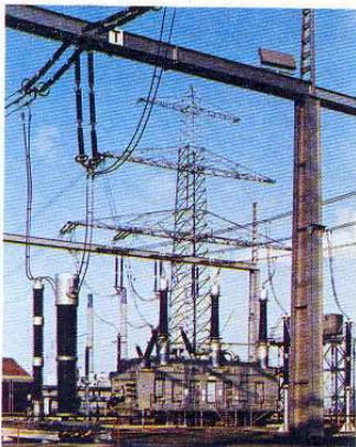
Fig. 15.71. Aislamiento mediante aire en una subestación de la red de alta tensión.
