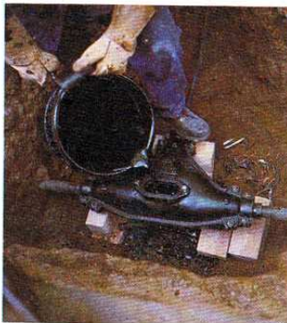
Fig. 15.79. Relleno de alquitrán en un empalme de cables.
