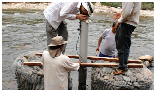
Colocación de la tubería de agua desde la bomba al tanque
