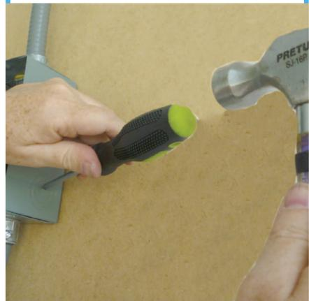
57. Cuando se afloje, saca el sobrante con unas pinzas. Asegúrate que el conector entre en el hoyo,
