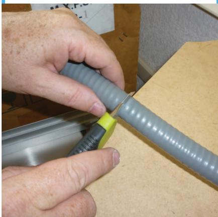
61. Pero el corta con unas pinzas la cubierta metálica.
