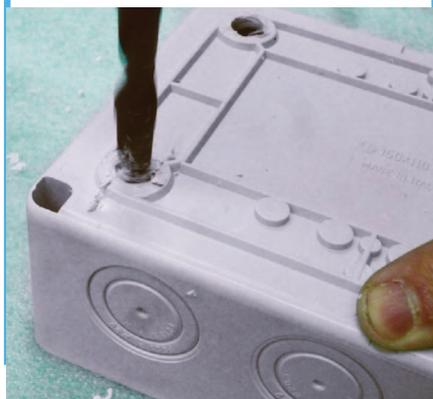
3. En la parte inferior de la caja se colocaran los conectores para los cables. Esto evitara que entre agua.
