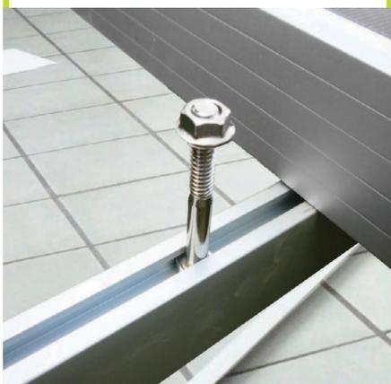
5. Coloca el siguiente panel solar, evitando golpear el panel con el tornillo del separador.
