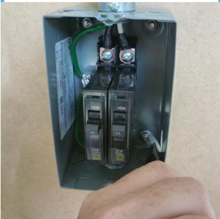
58. Coloca el conector y atora la tuerca por dentro de la caja.
