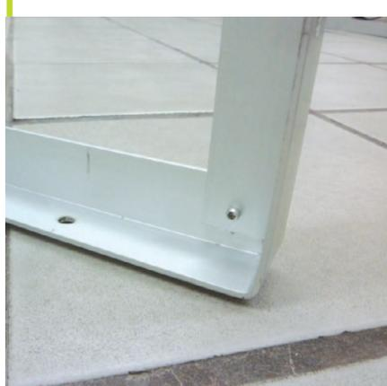
12. En el riel "E" desliza 6 tornillos SS 1/4" X 1/2". (Uno en cada extremo que se fijaran a cada base y 2 tornillos para cada inversor.)
