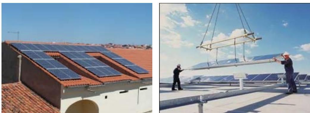
Figura 1: Instalaciones FV residenciales
