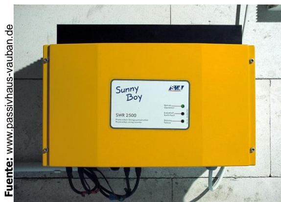
Figura 12: Inversor de voltaje
