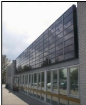
Figura 10. Paneles solares integrados en fachada. Fuente: Free Energy Europe.
