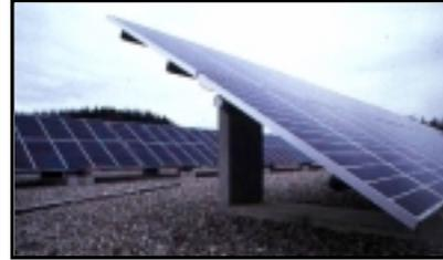
**Figura 8.** Estructuras utilizadas en los paneles solares para conseguir la orientación deseada. Fuentes: Construible.es y Consolar.
