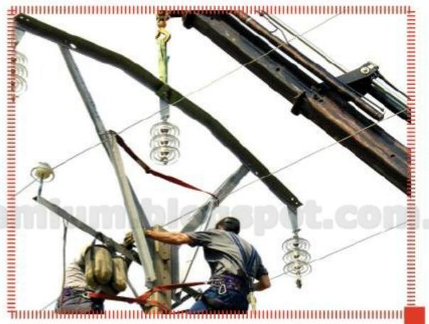
Las líneas de alta tensión se sujetan a las torres metálicas con algún material aislante, como el vidrio, la porcelana y la cerámica.
